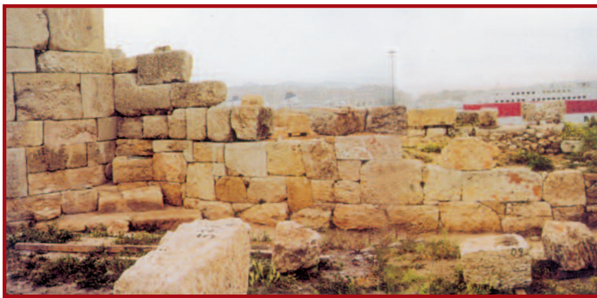
Το παρά την πύλη της Ηετιώνειας τμήμα του δυτικού τείχους (φωτογραφία εξωτερικής όψης)
