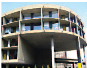
Carpenter Center - Βοστόν
