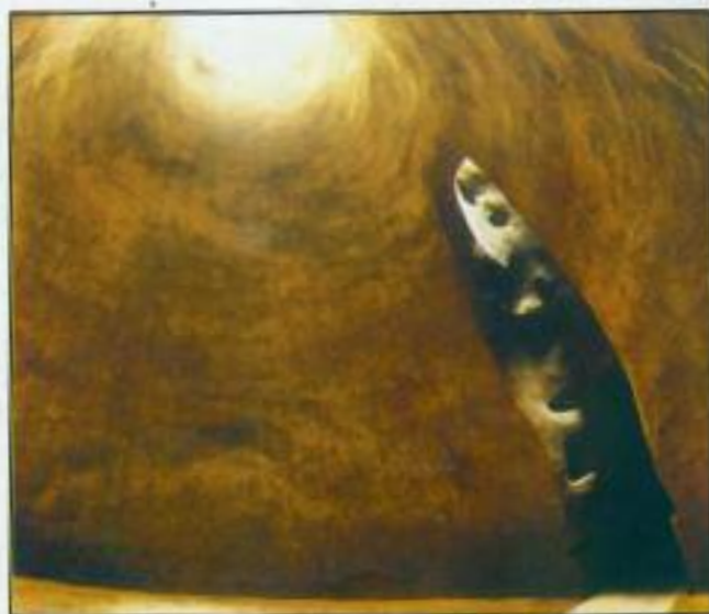
Άποψη του εσωτερικού της δεξαμενής
