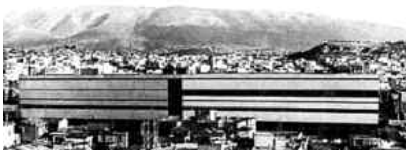
ΕΙΚ. 9 Κτήριο FIX παλαιά
