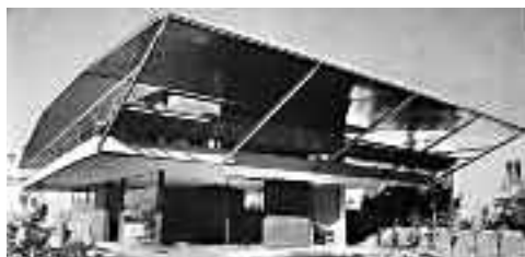
ΕΙΚ. 4 Κατοικία στη Γλυφάδα
