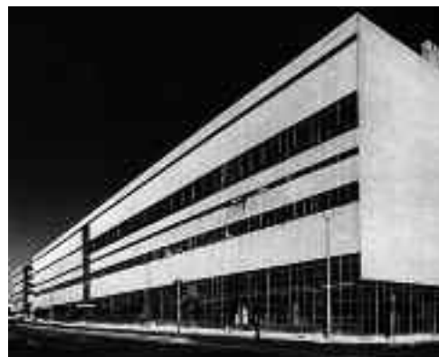
ΕΙΚ. 10 Κτήριο FIX παλαιά
