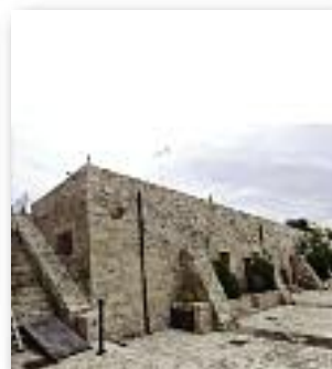
Εικ. 14. Δεξαμενές νερού
