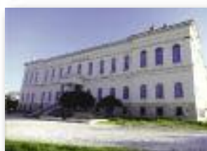
Εικ. 8. Βόρεια όψη
