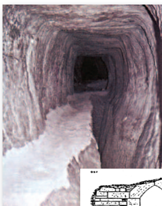
Εικ. 6. 7. Φωτογραφία και τομή του εσωτερικού του υδραγωγείου (διακρίνεται ο διάδρομος επίσκεψης και το κανάλι με τον αγωγό)
