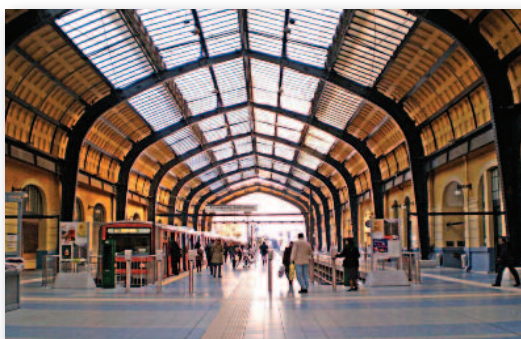
Εικ. 19. Εσωτερικό σταθμού -2 (άρθρο ανακαίνισης)
