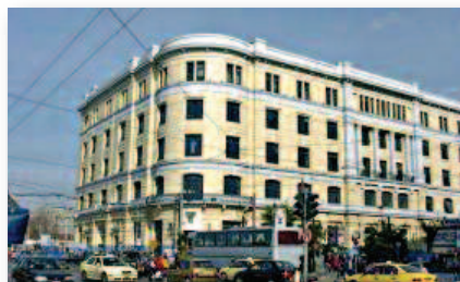
Εικ. 29. Όψη (χωρίς γέφυρα)
