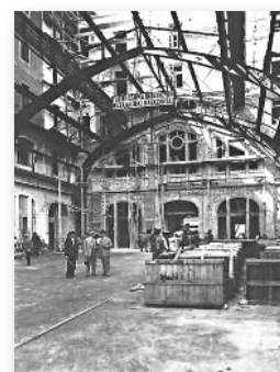
Εικ. 21. Κατασκευή θόλου -2 (Λεύκωμα 130 χρόνων)
