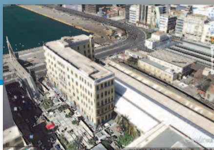
Εικ. 17. Αεροφωτογραφία του σταθμού (Google earth)
