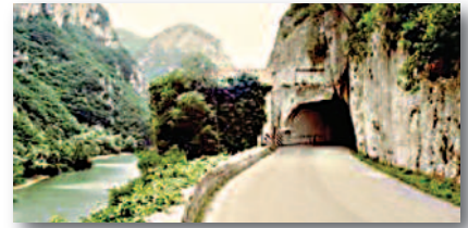
Εικ. 12. Σήραγγα της via Flaminia στην Ουμβρία (Ιταλία)
