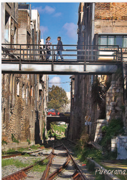
Εικ. 7 Γέφυρα του Ρεμπέτη (Pireorama)
