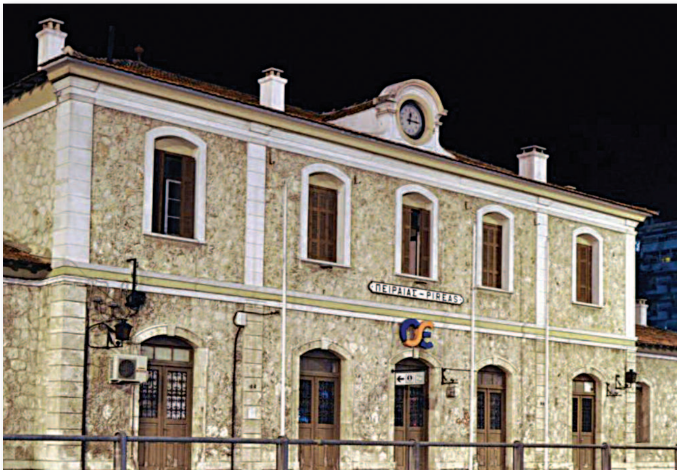
Κεντρικό τμήμα σταθμού (Δημ. Αϊβαλής, Αρχιτέκτων)
