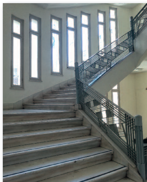
Εικ. 15 Κλιμακοστάσιο (Γ. Γάρδας)
