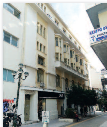
Εικ. 6 Οψη οδού Σωτήρος (Γ. Γάρδας)
