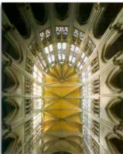
Εικ. 10. Το σύστημα των οξυκόρυφων τόξων του γοθτικού ναού
